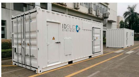
La nheobox est une solution de production énergétique « tout en un », équipée de modules de production, de stockage et de distribution intégrés, prête à alimenter.
